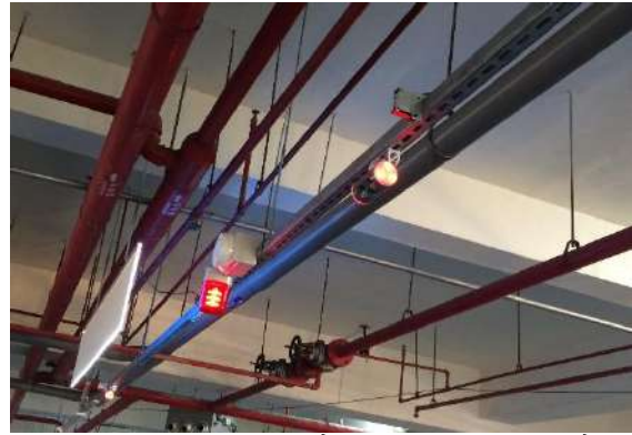
圖 3-3-10 無障礙車位語音提示與車位在席系統(2)
