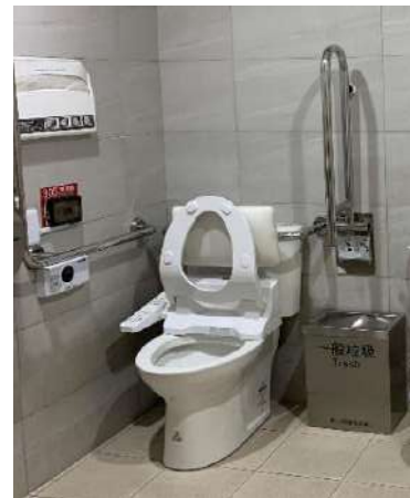
圖 3-2-14 性別平等與多元尊重優化設施(4)一無障礙廁所增設免治馬桶、感應式沖水
