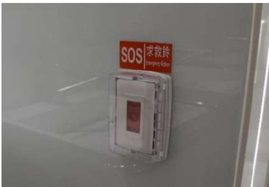
圖 3-2-21 隱私性及安全性之面向優化設施(3)—圖系統連線緊急求救
