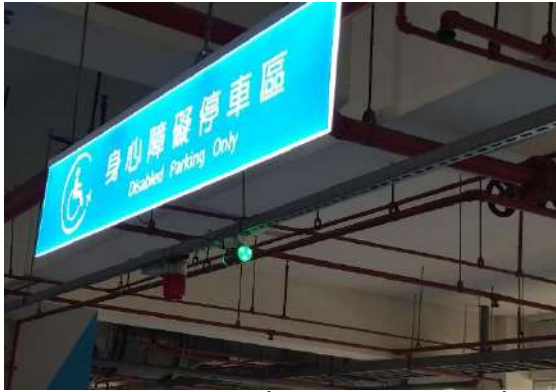
圖 3-3-9 無障礙車位語音提示與車位在席系統(1)
