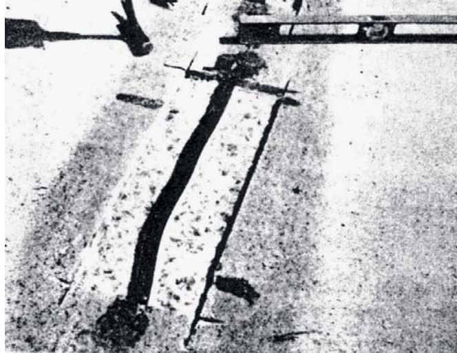
b. 以臨時彈性嵌入物或塑膠密封劑填塞加寬裂縫
