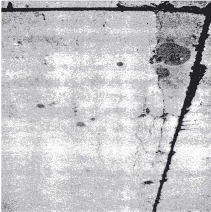
c. 填以環氧樹脂後之損害道面磨除
