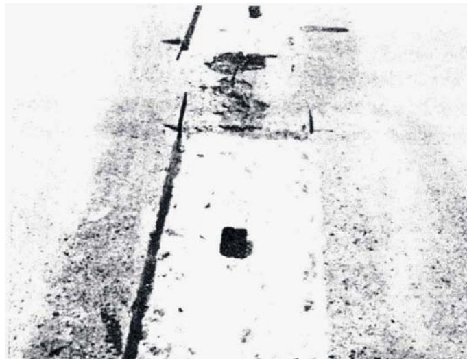
a. 將溝槽（沿裂縫切出）區域道面材料清除
