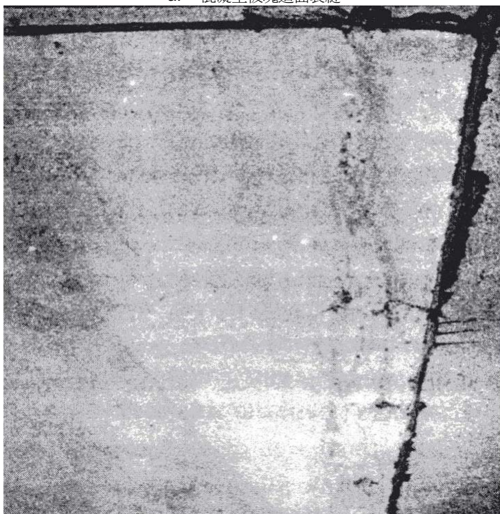
b. 損害道面磨除後之狀況
